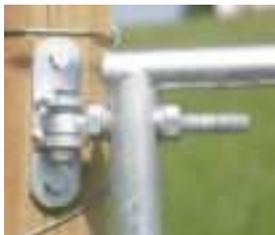
Montageversatz der Scharniere kann durch Verstellen der Gewindegewindescharnierbolzen ausgeglichen werden!
