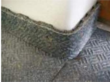
Sockelleiste aus OPTIMAL-Boxenplatten
