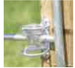
Montageversatz der Scharniere kann durch Verstellen der Gewindegarniturbolzen ausgeglichen werden!
