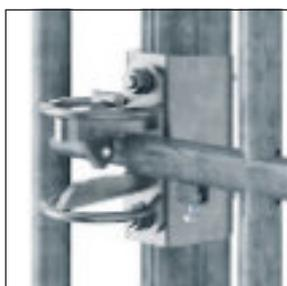
Montageversatz der Scharniere kann durch Verstellen der Gewindegewindesteifbolzen (beliebig höhenverstellbar) ausgeglichen werden!
