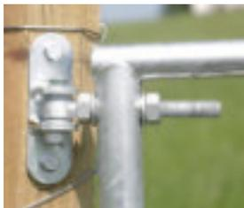
Montageversatz der Scharniere kann durch Verstellen der Gewindegewindesteifbolzen ausgeglichen werden!
