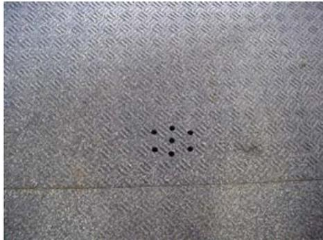
Verlegungsnaht und Ablauf im Boden
