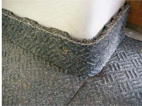
Sockelleiste aus OPTIMAL-Boxenplatten
