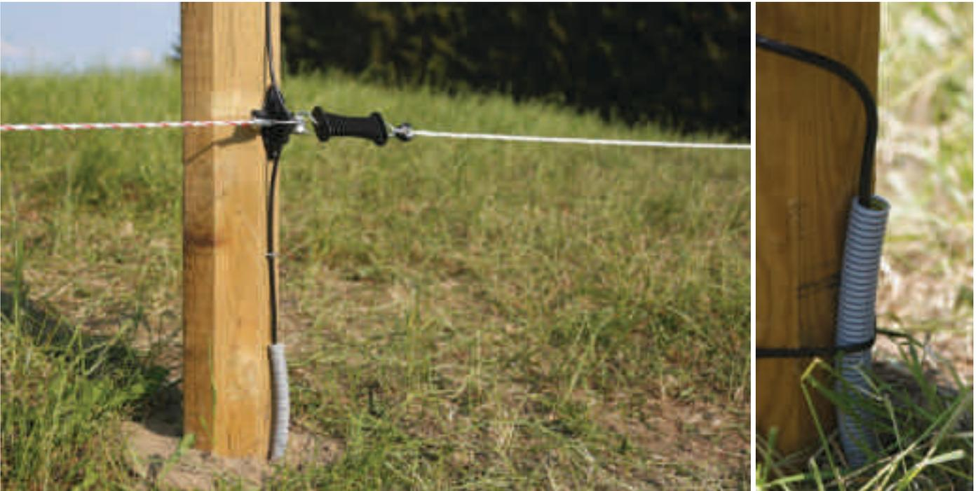
Tip: Untergrundkabel unbedingt in einem Kunststoffrohr verlegen, um Beschädigungen am Kabel zu verhindern!
