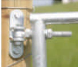
Montageversatz der Scharniere kann durch Verstellen der Gewindegewindestammerbolzen ausgeglichen werden!
