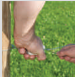
7. Loses Drahtende 5-mal um den Zaundraht wickeln
