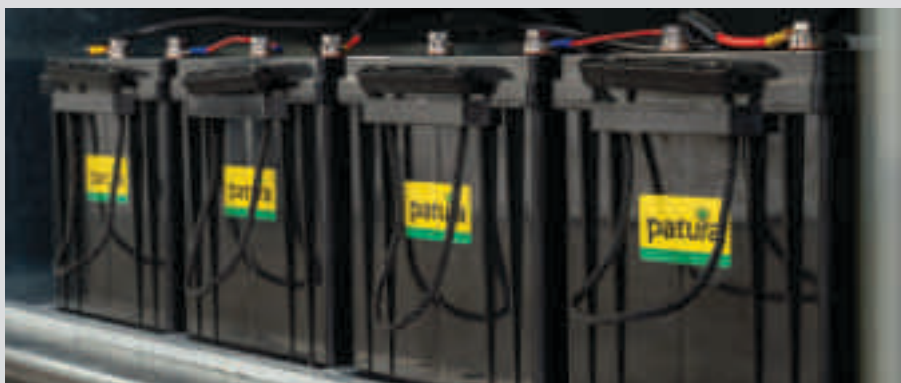
4 große Akkus mit je 200 Ah sorgen für lange Laufzeiten auch bei schlechtem Wetter.
