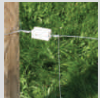
8. Drahtende lang lassen zur Querverbindung
