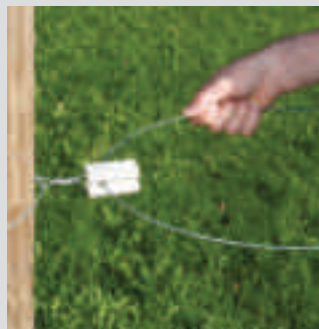
6. Zaundraht durch den Zugisolator hindurchziehen
