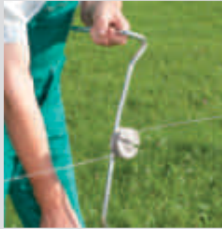
2. Spannbügel solange drehen bis die richtige Zaunspannung erreicht ist
