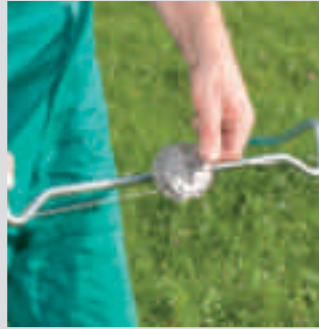
3. Spannbügel in den Draht einhängen, Sicherungsbügel einsetzen und Spannbügel entnehmen
