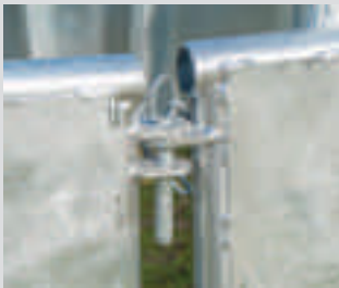
Verdeckte Steckbolzen
