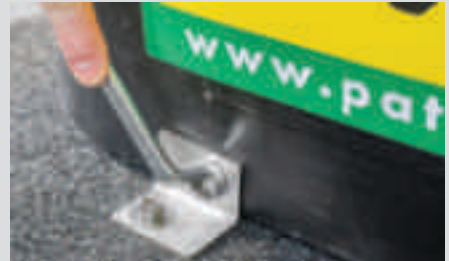
Montage auf einem überstehenden Betonsockel mit Haltewinkel
