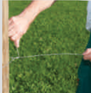
2. Loses Drahtende 3-mal um den Zugdraht wickeln
