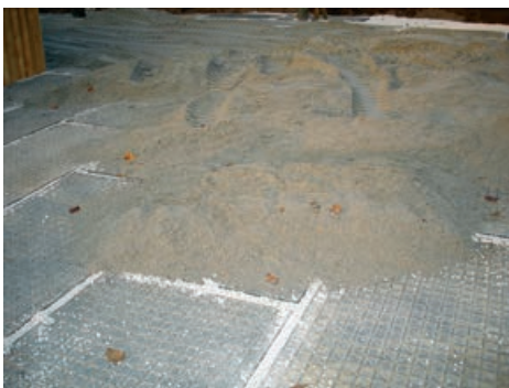
Fugenverfüllung und Aufbringen des Tretbelags
