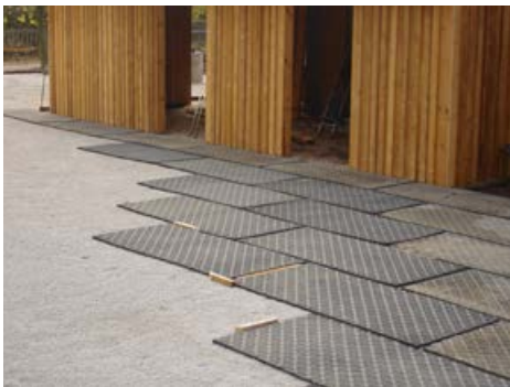
Kanthölzer als Verlegehilfe
