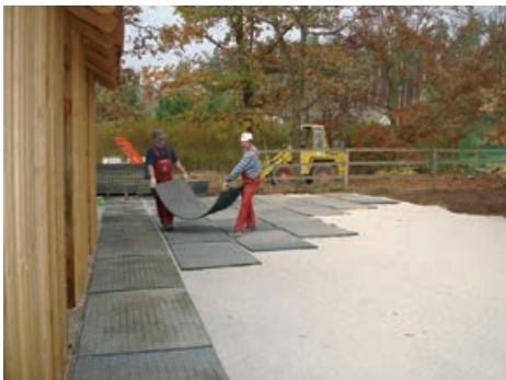
Verlegung der Optimal-Reitplatzplatten
