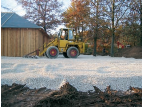
Aufbringen und Verdichten der Schotter-schicht
